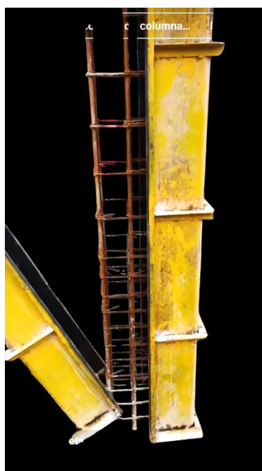
FORMALETA COLUMNA COMPLETA DIVIDIDA EN 2 PARTES
